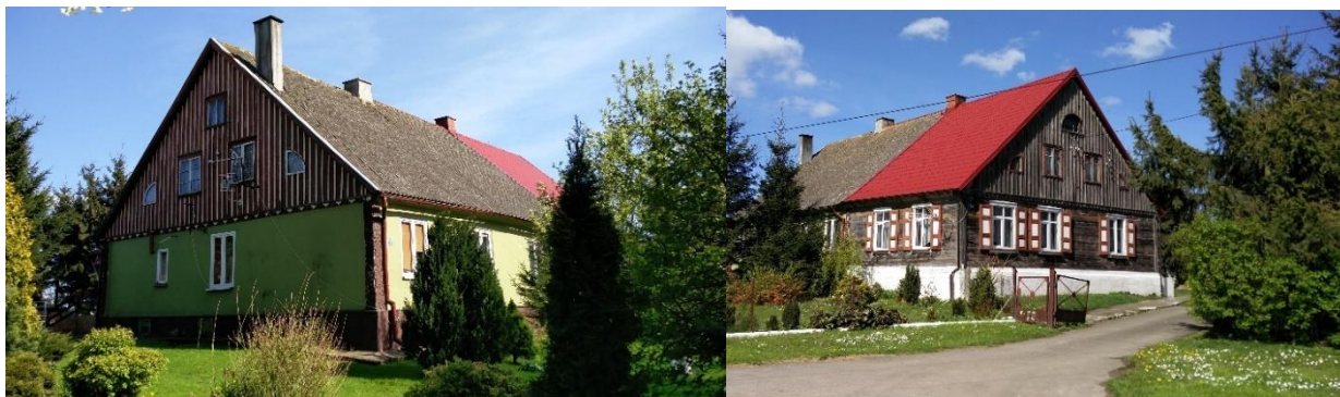
Unterschiedliche Gestaltung der Haushälften des ehemaligen Wiebehofs in Groß Mausdorf, die rechte Hälfte weitgehend im alten Stil belassen
