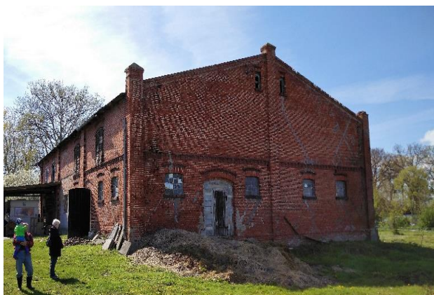
Der alte aus Ziegelsteinen gemauerte Stall
