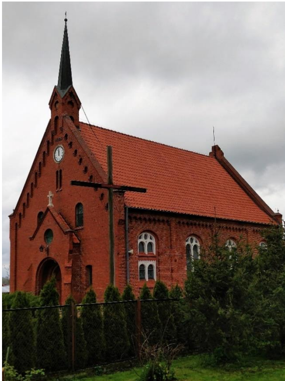
Ehemalige Mennonitenkirche in Montau
