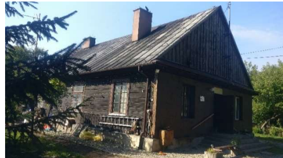
Ehemalige Mennonitenkirche Deutsch Kazun, der untere Teil der Giebelwand wurde zwecks Isolierung mit Spanplatten verkleidet.
